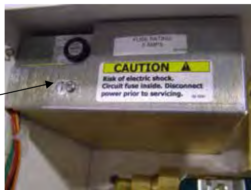
Conduit knockouts for 120 VAC
